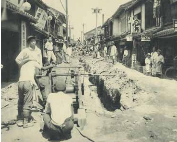
長江通りへの水道管理設工事風景 大正12年(1923)7月13日撮影 『尾道市水道寫真帖 大正十四年三月』(杭田嘉壽太発行)より
